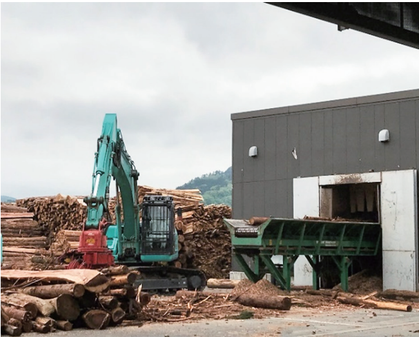
写真1 福井グリーンパワー大野発電所 (筆者撮影)
