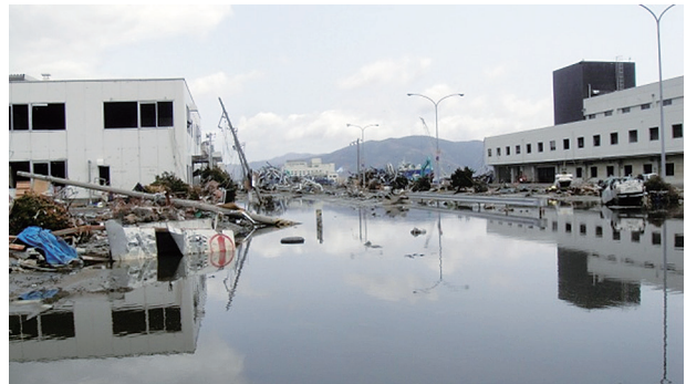
写真2 被災した石巻魚市場と水産加工団地
