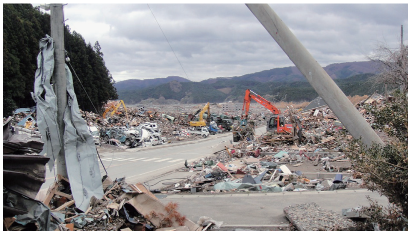
図10 被災直後の陸前高田市（酔仙酒造付近）
