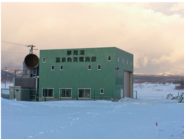
摩周湖温泉熱発電施設 外観
